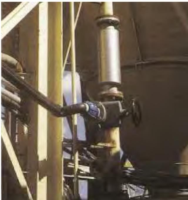
I prodotti MAIC infatti scompongono - a freddo anziché a caldo - le molecole di bicarbonato di calcio in tanti piccoli ioni: così, con il riscaldamento dell'acqua, non si determina più la formazione del carbonato di calcio, più comunemente noto con il nome di calcare.
